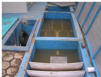
Prototipe Sumur Imbuhan Dalam (Oleh Pusat Litbang SDA di Banjaran-Bandung)
